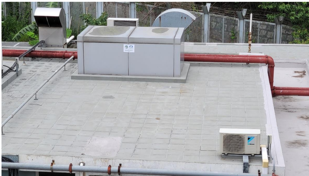
怡菁山莊 2 座天台隔熱塗層
