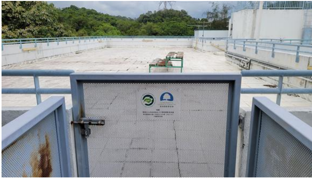
怡菁山莊 3 座天台隔熱塗層
